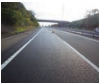
北陸自動車道（特定更新等） 魚津IC～黒部IC間舗装補修工事 (2017年度)
