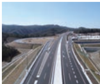
新名神高速道路 神戸舗装工事
