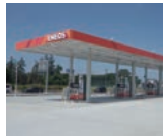
DDセルフ上尾小敷谷店 新設工事
