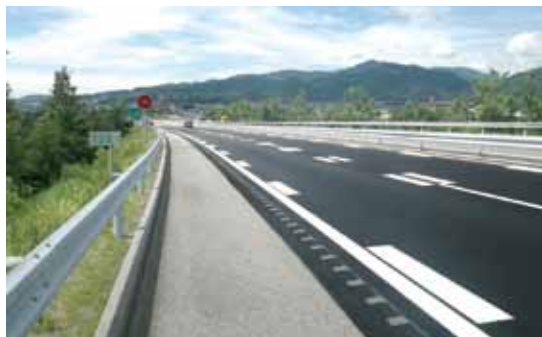
● 西日本高速道路株式会社 松山自動車道 三島川之江～西予宇和間 舗装補修工事 【愛媛県】
