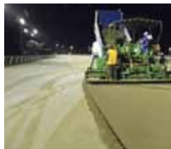
改修工事の施工状況
