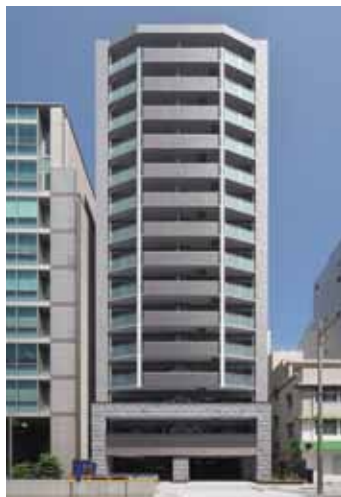
● 株式会社プレサンス コーポレーション (仮称)プレサンスロジエ 心齋橋新築工事 【大阪府】
