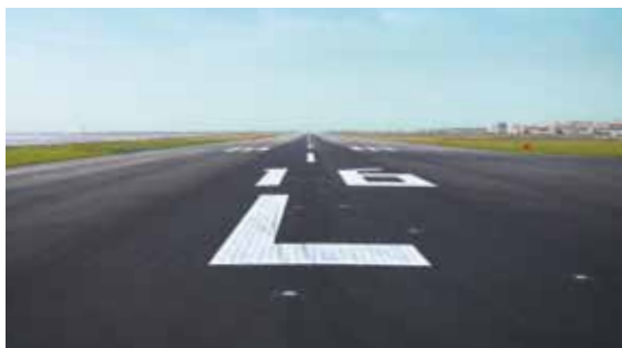
● 国土交通省関東地方整備局 東京国際空港C滑走路 舗装改良等工事 【東京都】
